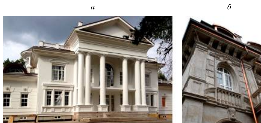
Рис. 10. Отделочные технологии в неоклассических (необарочных) современных зданиях светского назначения, уместные при возведении храмов (проекты автора): а – оштукатуривание архитектурных деталей по кирпичной кладке (усадебный дом, Вырицы, окрестности Санкт-Петербурга); б – архитектурные детали из естественного (искусственного) камня, накладываемые на плоскость фасада (особняк, Одинцовский р-н, Московская обл.)
